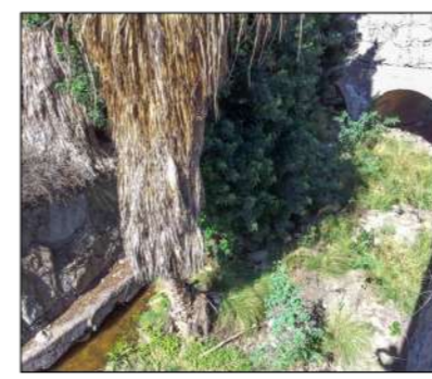
Las tres imágenes muestran diversos aspectos del deficiente mantenimiento o diseño de las infraestructuras hidráulicas. En la de la izquierda se observa vegetación arbórea, sedimentos y fuga de agua (presumiblemente residual o depurada), en la canalización del barranco de Puerto Rico. En la del centro la reducción de la sección útil del canal bajo el ramal de conexión con el barranco de El Lechugal. La imagen de la derecha muestra un imbornal de reducidas dimensiones y completamente obstruido cerca de la carretera GC-500
